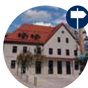
Rathaus Oberhausen Schulstraße 1 Oberhausen
